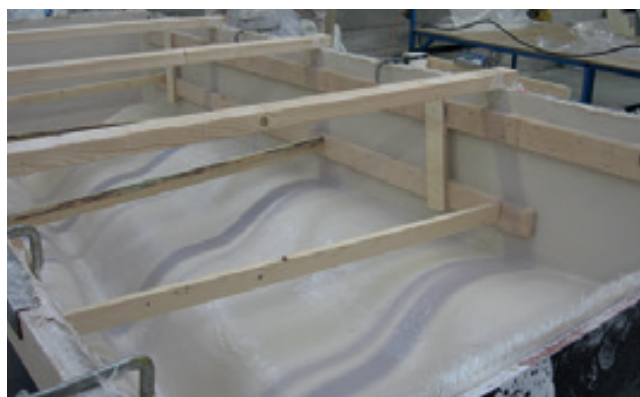
Zalaminowany element wraz z belkami sklejkowymi o grubości 36mm umieszczonymi po bokach
